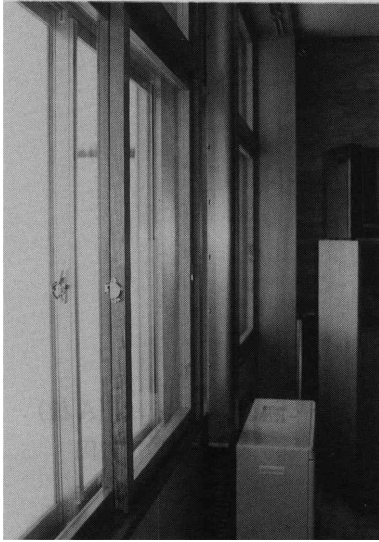
マツの木製窓(旭川第1中学校)
