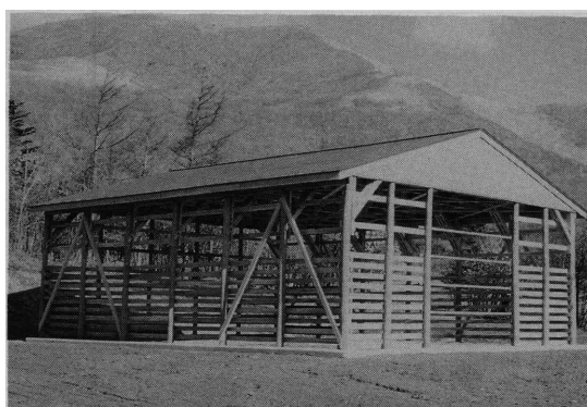
写真 14 PT型ハウスによる乾草舎 (エリモ)
