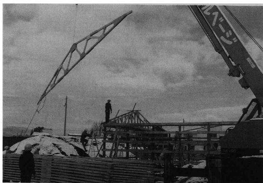
写真 13 建築中の PT型ハウス (林産試験場)
