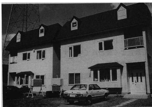
写真 4 外壁にカラマツセメントボードを用いた住宅(恵庭)
