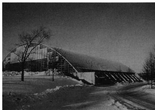
写真6 スパン85mの集成材アーチによる 体育館(フィンランド)
