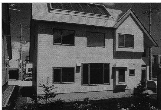
写真 2 木製窓の住宅(旭川)
