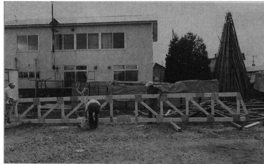
写真4 緩いこう配の片流れ屋根トラス
