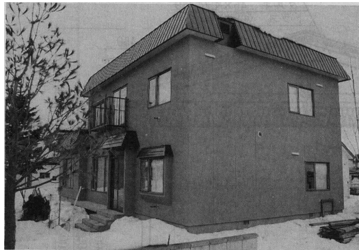
写真5 無落雪型の屋根トラスを用いた住宅 能です。
