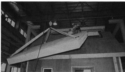
写真10 屋根パネルの施工
