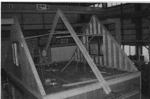
写真9 登り梁および2階壁パネルの建て上げ
