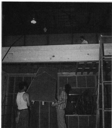
写真8 2階床パネルの施工
