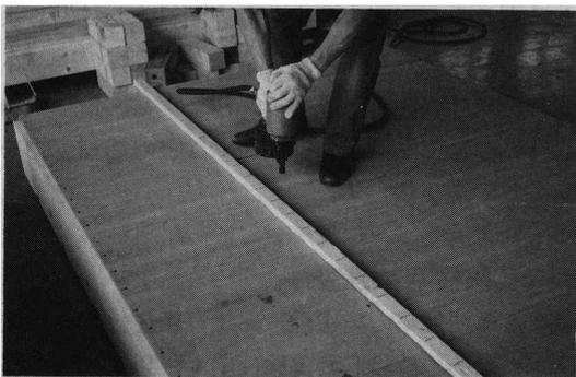
写真 3 パネル面材の釘打ち
