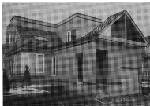
写真1 サイディングへのカラマツセメントボード使用例
