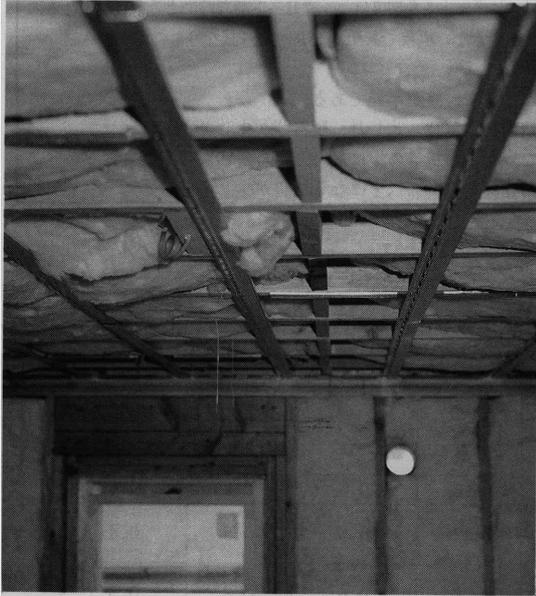
写真1 断熱材の入れ方の悪い例
