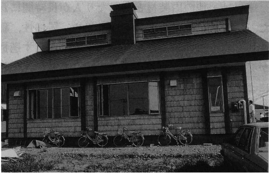
写真3 ウッドシングルと木製窓
