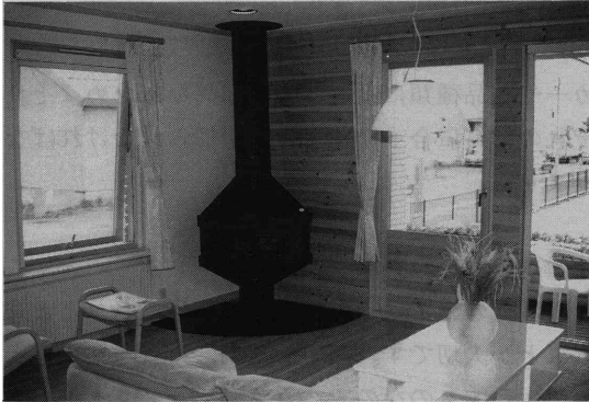
写真3 オウシュウアカマツ羽目板の壁面 (スウェーデンハウスモデル住宅 - 札幌市)
