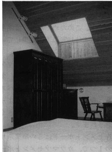
写真6 カラマツ羽目板による傾斜天井 (木の家 - 札幌市)
