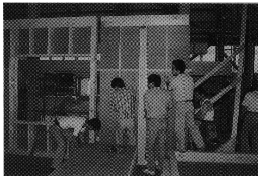
実験住宅の建て上げ
