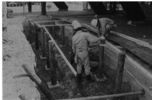
写真2 丸太杭とコンクリート板
