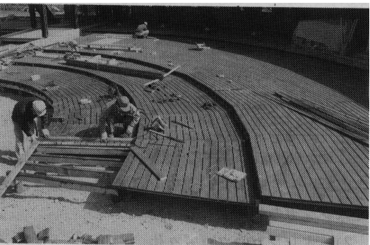
写真5 床板の張り上げ
