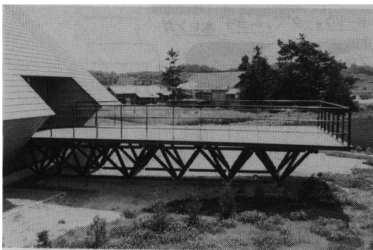
写真.1 スペースフレームによるサンデッキ
