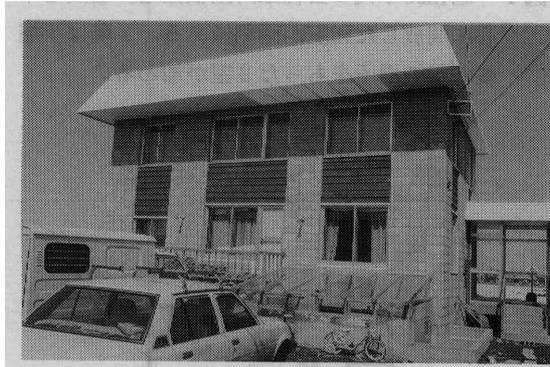
写真4 最近では火山灰ブロックによる外断熱二重壁（中間に断熱材を入れ、室内ではブロックの蓄熱を利用する）が試みられている（芽室町）。
