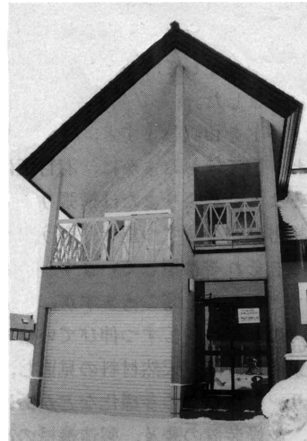
写真5 釘打ち作業を改善した外壁材の施工例(旭川ウッドタウン展示住宅)
