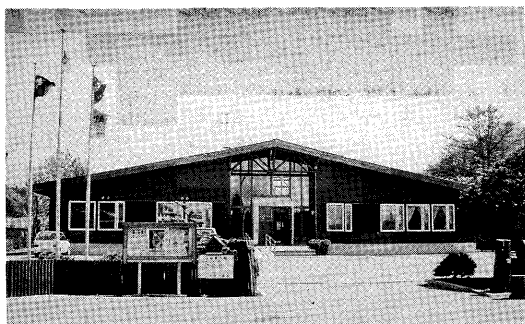
写真6 カラマツ外壁材（厚岸林務署）
