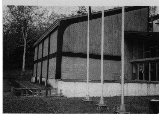
写真1 公共建築物の外装改修工事(外壁材A)
