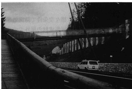
写真21 国道の上に架かる木造橋（スイス）
