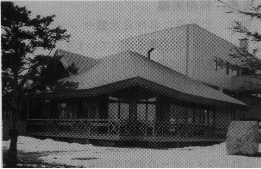
写真3 旭川営林支局展示棟
