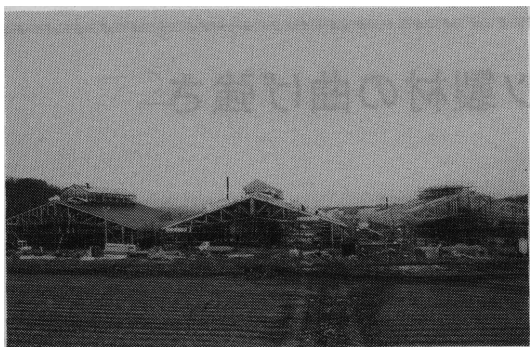
写真7 建設中の(協)ウッデイあさひかわ 新工場
