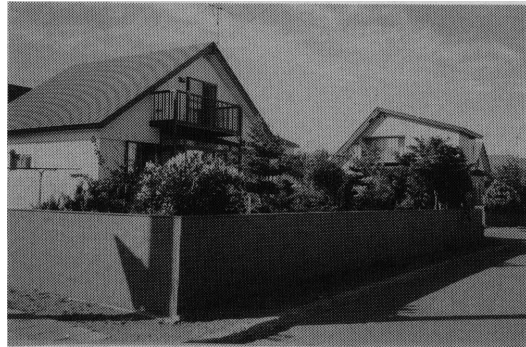
写真2 1.5mのへいに囲まれた住宅(石狩町花川)
