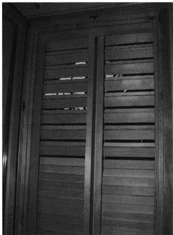
写真6 試作したよるい戸 (よるい戸閉, ガラリ開)
