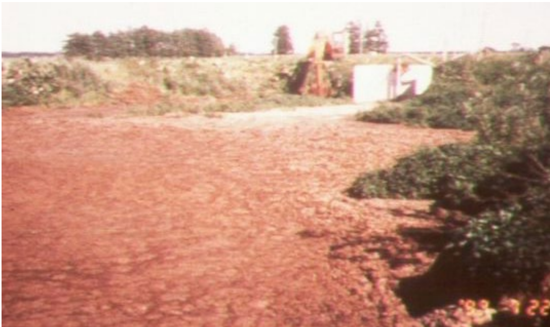
写真1 雨水の混入でスカムが厚くなり攪拌ができない。
