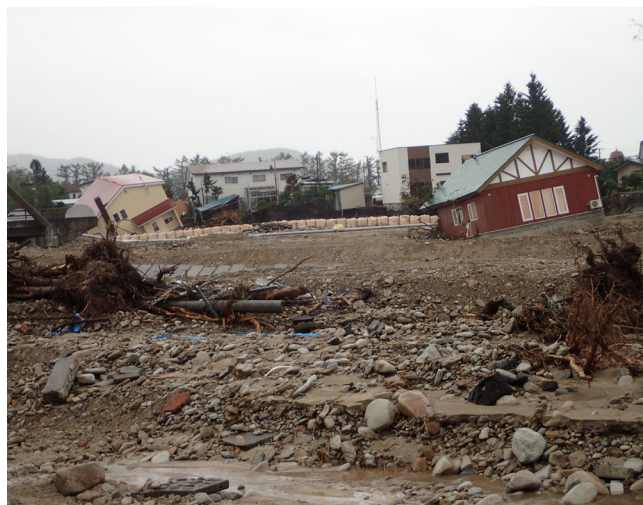
平成 28 年（2016 年）北海道豪雨（十勝清水ベケレベツ川）土石流と洪水による侵食で被災した家屋
