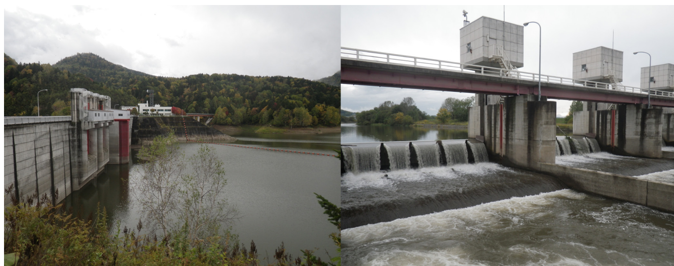
北見市の上水道水源である鹿ノ子ダム（左）と取水施設である常呂川第1頭首工（右）
