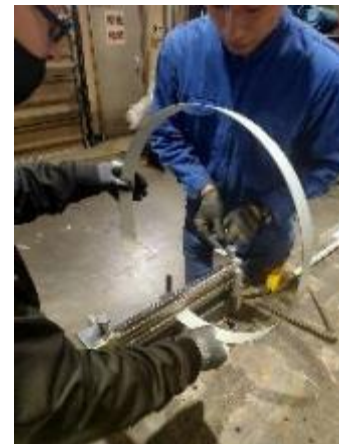
ロールベンダーによる タガへの曲げ加工
