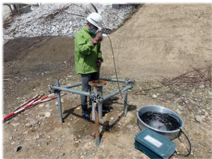
温泉の井戸に水位計を設置
