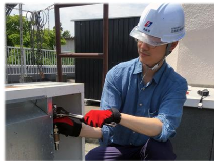
太陽熱集熱器を屋上に設置
