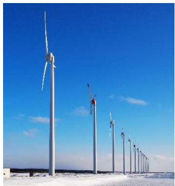
風力発電設備
