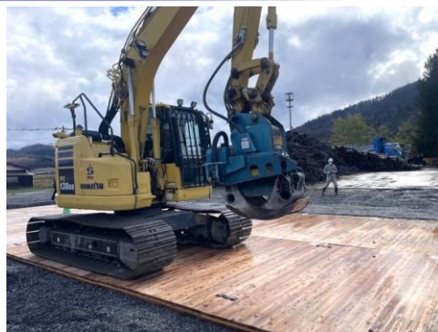
敷鉄板に替わるCLT敷板
