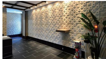
道産天然資源を活用した調湿内装タイルを焼かずに製造する技術を開発。
