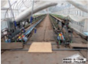
ハウス室温昇温試験の配管敷設状況
