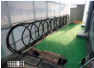
トイレハウスに設置した排湯放熱配管の状況
